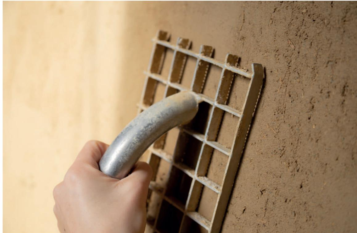
bestehen. Aber auch auf andere Untergründe – vorausgesetzt sie sind griffig genug – kann ein Lehmputz aufgebracht werden, beispielsweise auf Mauerziegeln, Gips- oder Kalkputz oder Gips-Trockenbauplatten.
