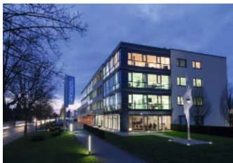
Hier entstehen Innovationen für eine nachhaltige Zukunft: Der Firmensitz von DENIOS an der Dehmer Straße in Bad Oeynhausen
